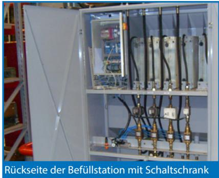
Rückseite der Befüllstation mit Schaltschrank
